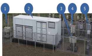
1 – Выходной реактор 2 – Блок силовых ячеек и управления 3 – Входной реактор 4 – Токоограничивающий резистор заряда 5 – Вакуумный выключатель
